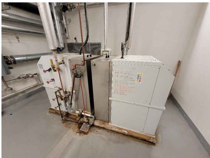
Obrázek 16 Parní vyvíječe (původní)
