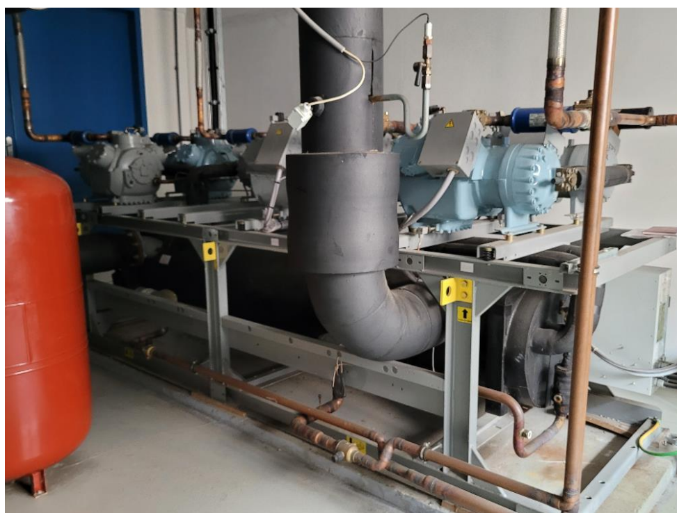
Obrázek 17 Pohled na jednotku kompresorového chlazení
