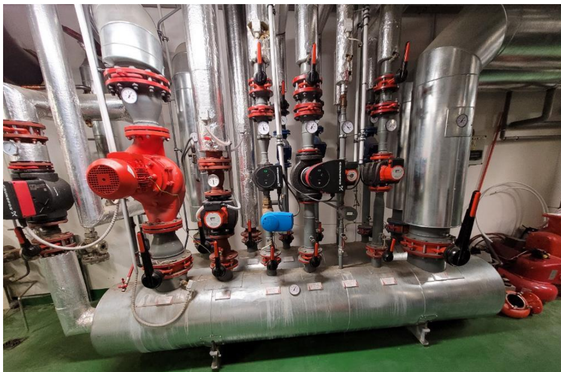
Obrázek 10 Pohled na rozdělovač topné vody
