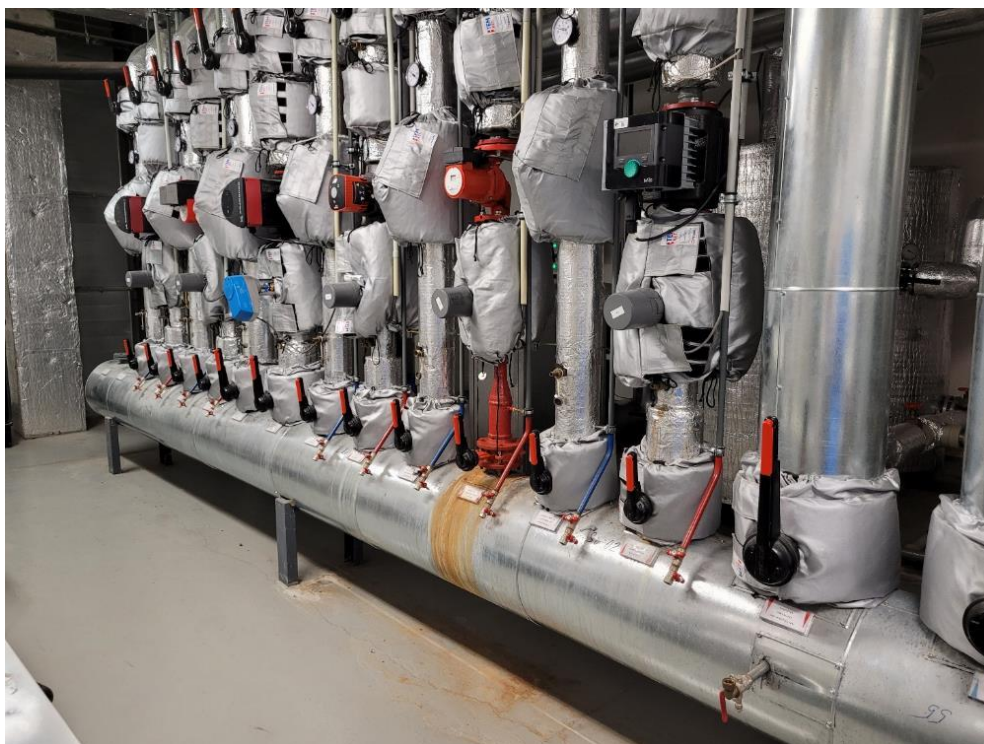
Obrázek 12 Pohled na rozdělovač topné vody
