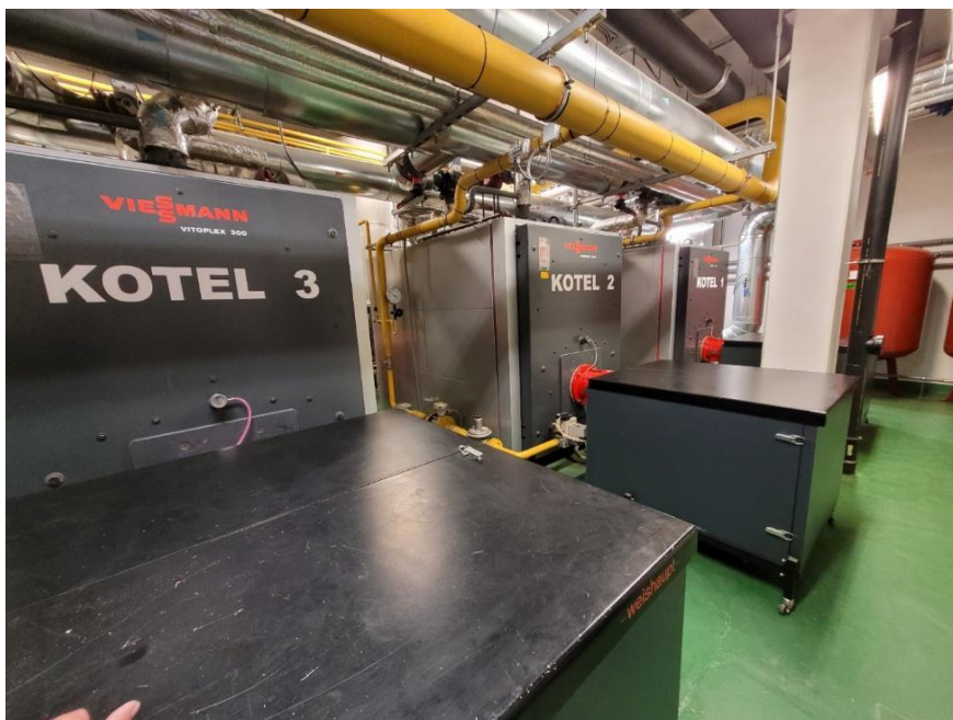
Obrázek 4 Pohled na plynové kotle Viessmann
