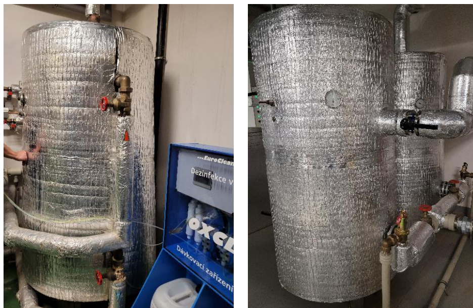
Obrázek 9 Pohled na akumulační nádoby (vlevo v objektu SO 06 a vpravo v objektu SO 02)
