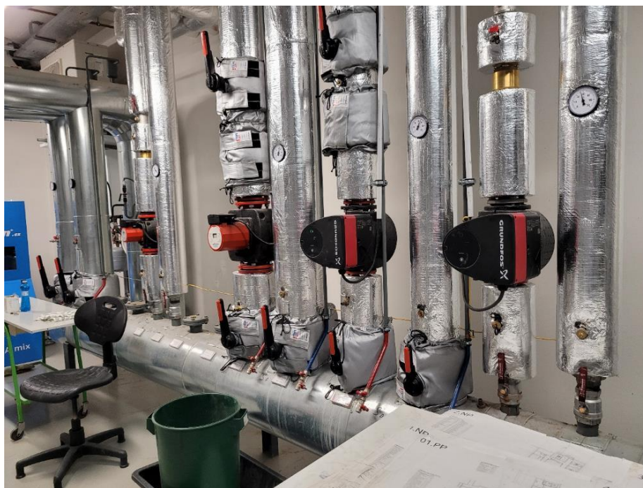
Obrázek 11 Pohled na rozdělovač topné vody TZB-VZT
