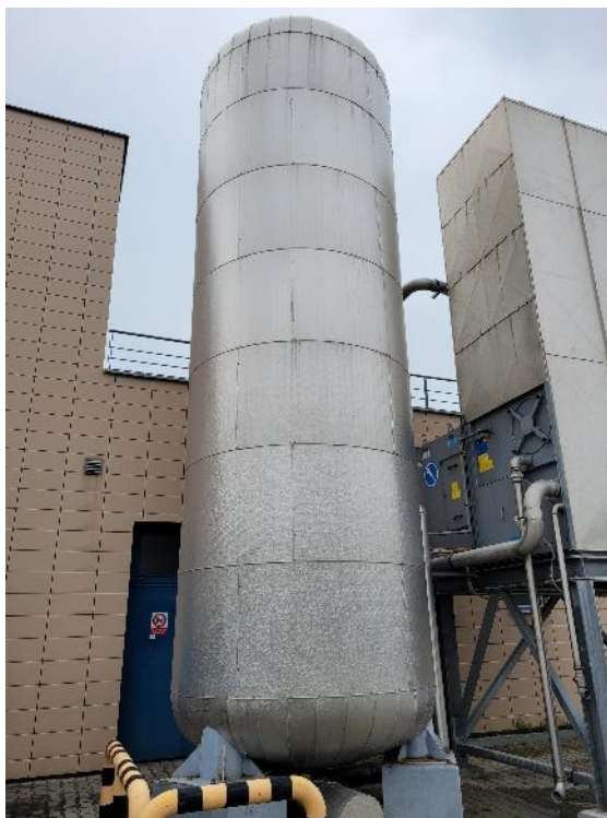
Obrázek 7 Pohled na akumulaci nádrží topné vody
