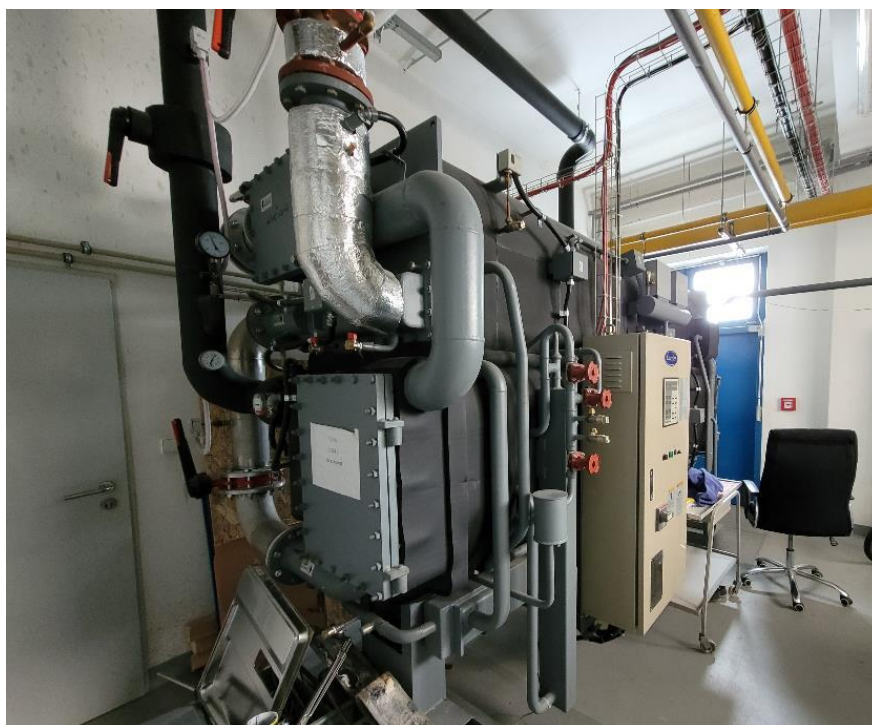
Obrázek 18 Pohled na jednotku absorpčního chlazení
